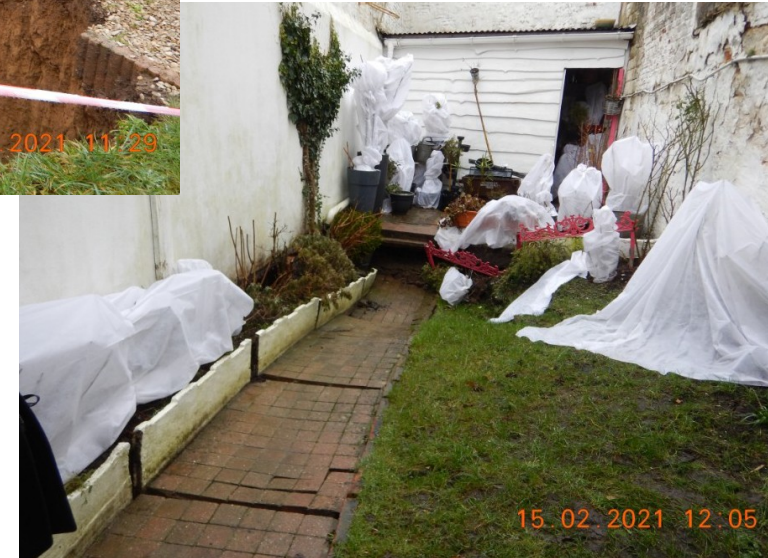
Effondrement et désordre sur bâti à Montreuil Photo DDTM
